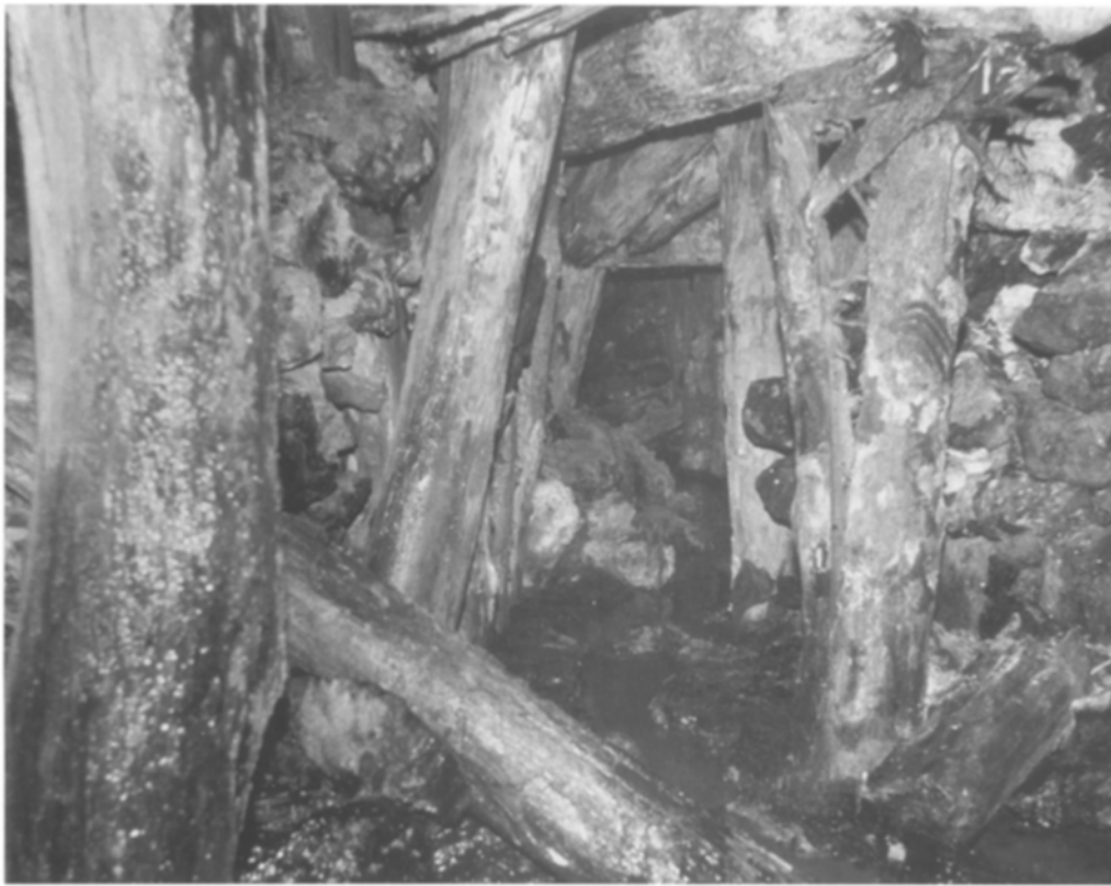
Fig. 1. Auszimmerung einer Strecke im Erzbergbau des 17. Jahrhunderts, die lichte Höhe der Baue beträgt ca. 1,50 m. Die Verwendung ungeschälter Stämme von Pappeln, Birken, Weiden und Kirschbäumen konnte festgestellt werden. Die Verwendung dieser Baumarten zur Grubenzimmerung ist ganz ungebräuchlich und belegt Holzangel. Viele 1000 m 3 Raum unter Tage waren in dieser Weise ausgebaut, der Holzbedarf enorm. Grube „Glückauf“ bei Straßberg/Harz. (Alle Fotos: Deutsches Bergbau-Museum Bochum)
